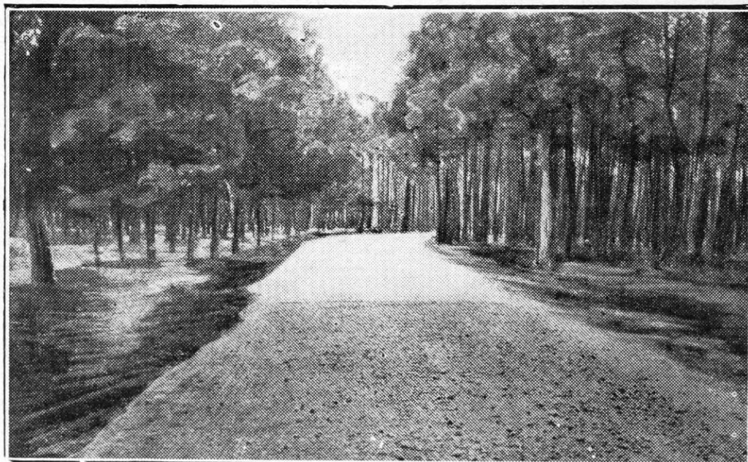
Fig. 2. — Une vue du circuit du Mans après l'épreuve de 1925 (au premier plan) macadam ordinaire ; (au second plan) chaussée silicatée
