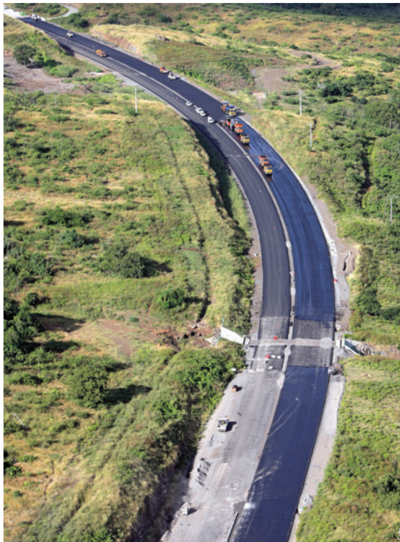
Photo 1 Vue générale mise en œuvre chaussées General view – Pavement works
