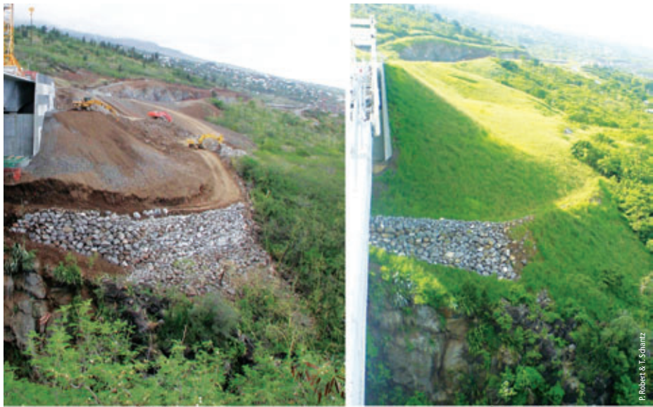
Photo 2 Quart de cône et modelage ouvrage d'art (OA) Ravine Chaloupe et section courante Quarter cone and structure modelling (OA), Chaloupe Ravine and normal road section
