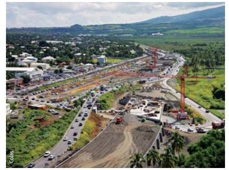
Photo 2b Avancement des travaux au mois de décembre 2007 Work progress in December 2007
