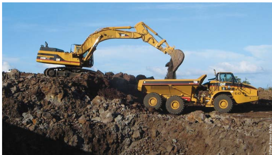
Photo 3 Terrassement des matériaux Earthworks
