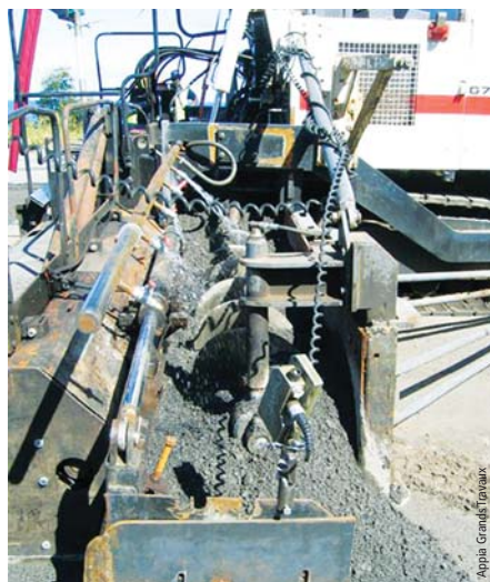
Photo 3 Table de finisseur avec GNT Paver screed for untreated roadbase material
