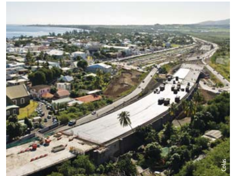
Photo 2c Les travaux en juin 2007 Works in June 2007
