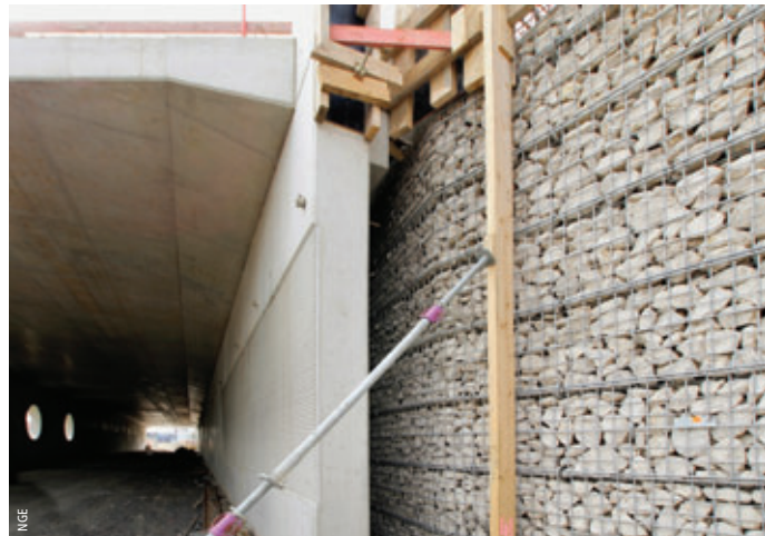
Photo 6 Le procédé de soutènement Tervoile The Tervoile support process
