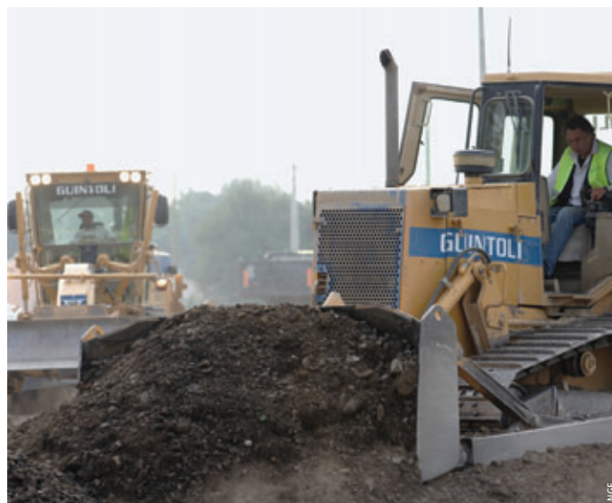
Photo 1 Engins de terrassement à Gardanne Earthwork machinery in Gardanne
