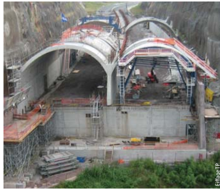
Photo 6 Tranchée couverte de Saint-Paul Saint-Paul cut-and-cover tunnel
