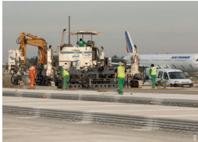
Photo 5 Dalle de béton sur une plate-forme d'Aéroport de Paris Concrete slab on a Paris Airport platform
