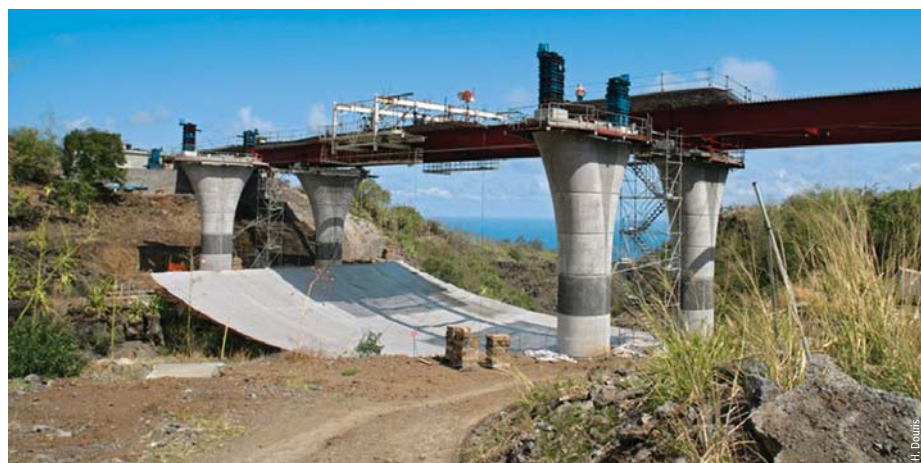
Pose de la géomembrane dans la ravine de Saint-Gilles Placing of geomembrane in Saint-Gilles Ravine
