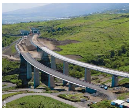
Photo 5 Vue générale du viaduc de la Savane General view of Savane viaduct
