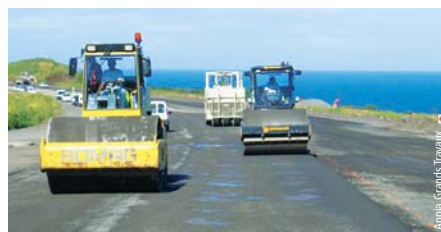
Photo 4 Atelier de compactage GNT réglage Roadbase compacting plant, levelling
