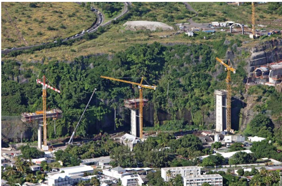
Photo 5 Le viaduc et la tranchée couverte Viaduct and cut-and-cover tunnel
