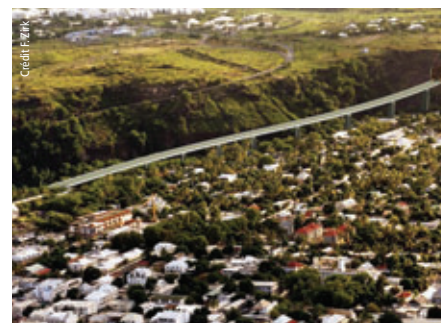
Photo 2 Photomontage du viaduc et de son entrée en tranchée couverte dans la falaise Photomontage of viaduct and its entry into cut-and-cover section in cliff
