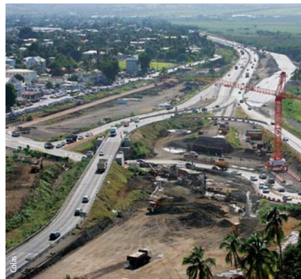
Photo 2a Avancement des travaux en avril 2007 Work progress in April 2007
