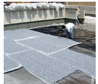
Le procédé Waterproof se met en œuvre en pose libre sur l'étanchéité bitumineuse Siplast
