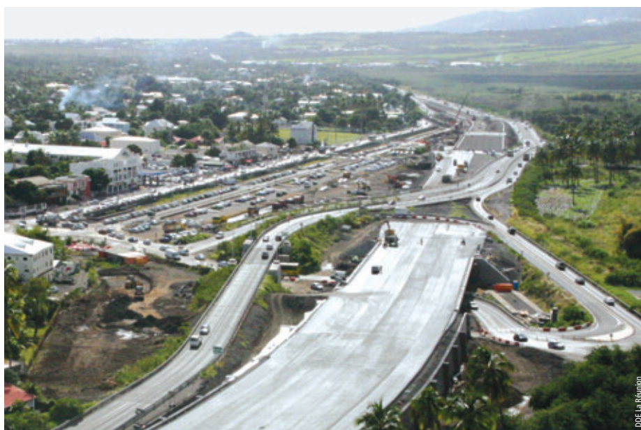
Photo 1 Vue générale du chantier à Saint-Paul, entre zone humide, zone urbaine et RN1 existante (juin 2008) General view of Saint-Paul worksite between wet zone, urban zone and existing national highway RN1 (June 2008)
