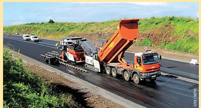
Atelier de mise en œuvre EME EME high-modulus asphalt application equipment
