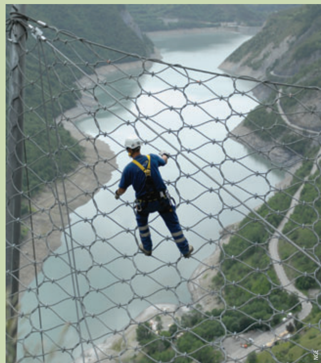
Photo 9 Des filets pare-pierres sur mesure Customised rock nets
