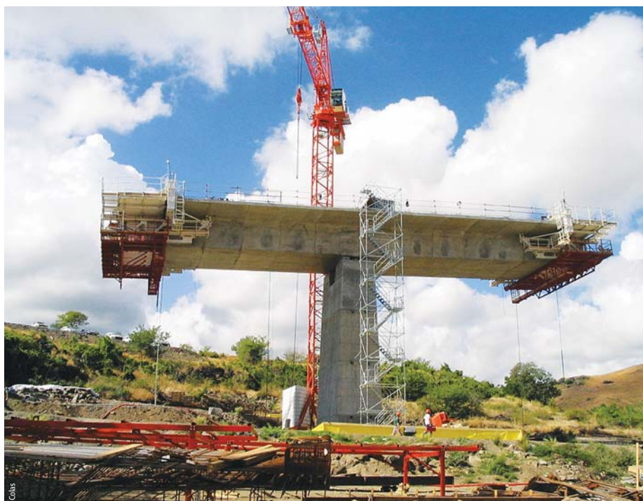
Photo 7 Phasage de construction avec équipement mobile Construction phasing with mobile unit
