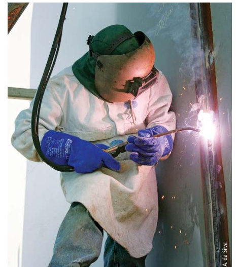
Ferrailage et soudure de poutre métallique Reinforcement and welding of steel beam
