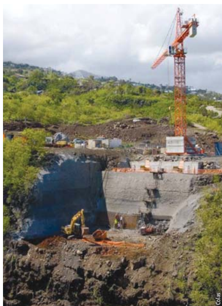
Photo 2 Travaux terrassement de la culée rive gauche Earthworks for left bank abutment
