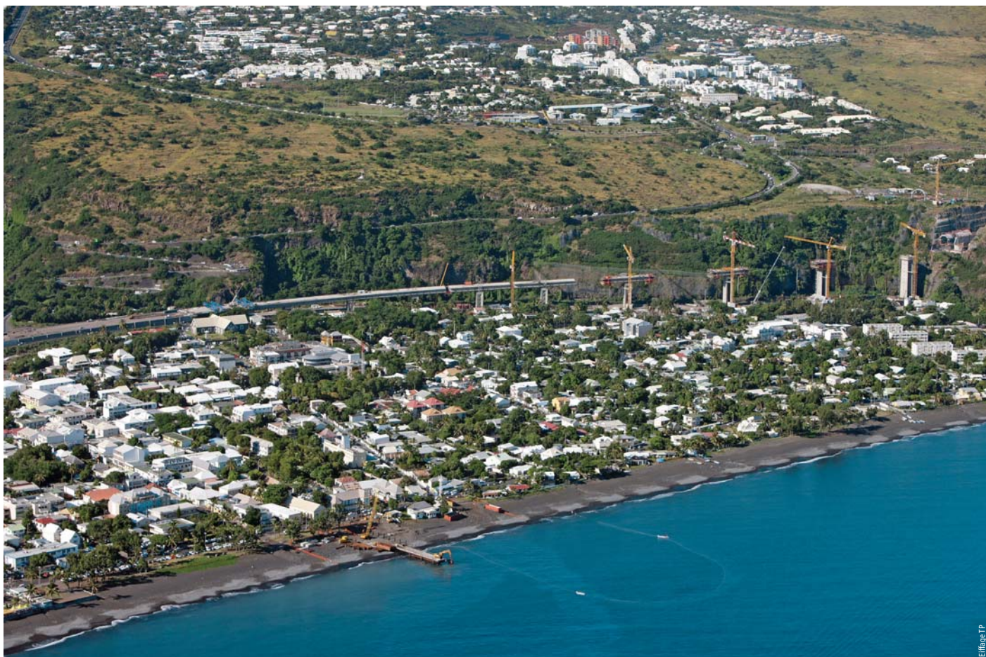
Saint-Paul et le Viaduc Saint-Paul viaduct
