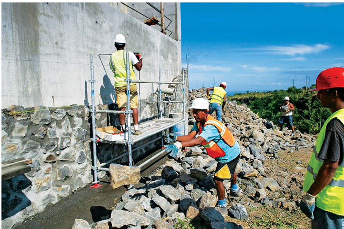
Habillage d'un mur « péi » Dressing a "péi" wall
