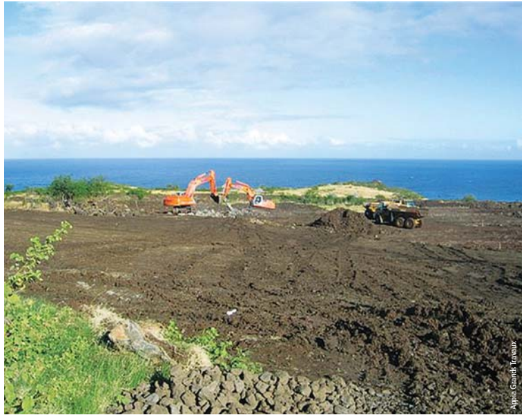
Aire de fabrication en cours de terrassement Manufacturing area earthworks
