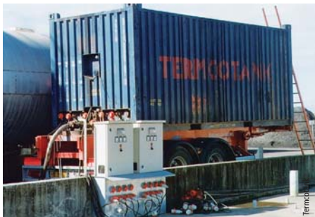
Photo 2 Conteneur de bitume en cours de réchauffage Bitumen container being heated
