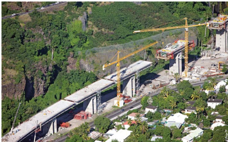
Photo 1 Construction en encorbellement Cantilever construction
