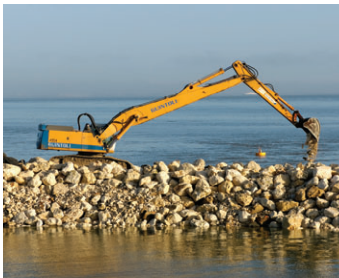
Photo 10 Digue à Port Médoc Port Médoc digue
