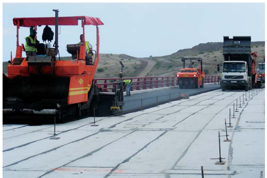
Photo 9 Mise en œuvre Betoflex sur OA Application of Betoflex on engineering structure
