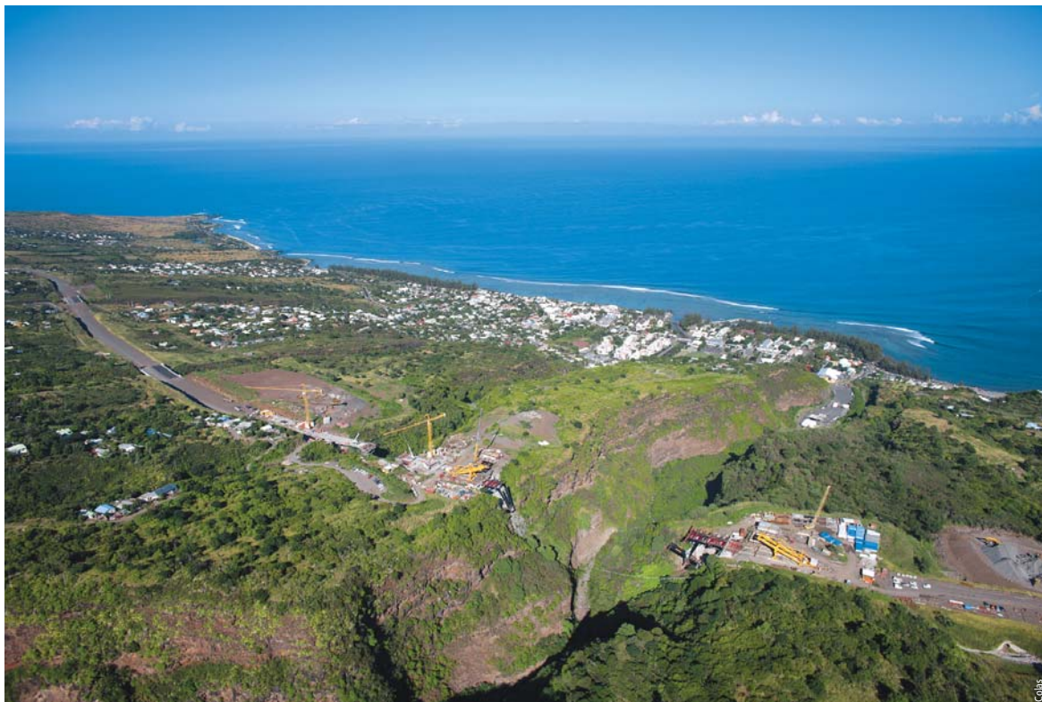
Photo 1 Vue générale de la ravine Fontaine General view of Fontaine Ravine
