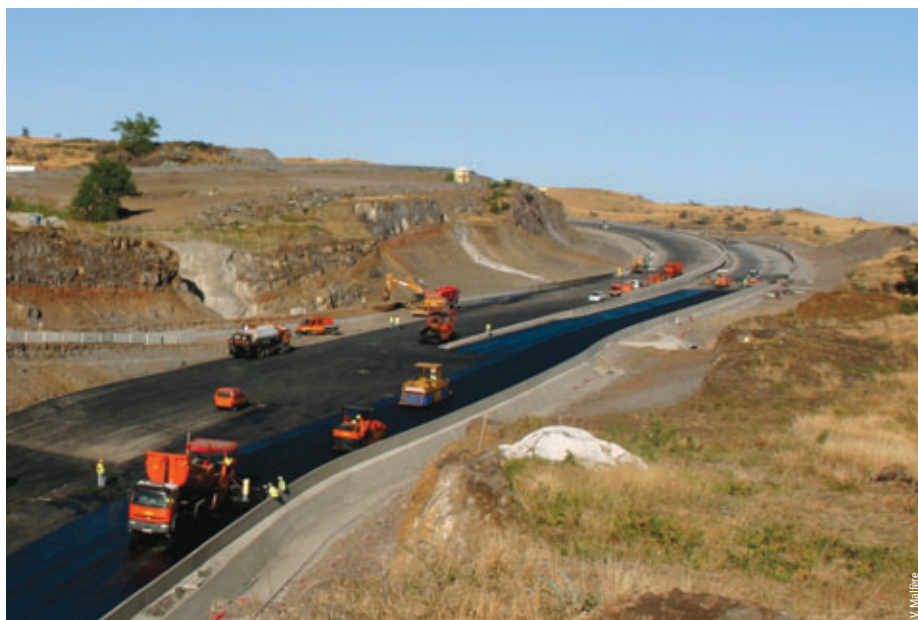
Photo 7 Mise en œuvre des enrobés dans une zone en déblais (juillet 2007) Application of asphalt in cutting zone (July 2007)
