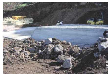
Photo 2 Béton de substitution sur C4 Substitution concrete on C4
