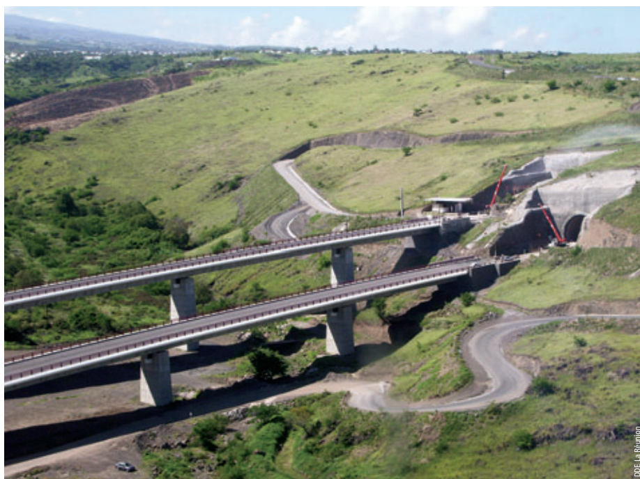
Photo 6 Viaduc de Fleurimont et têtes nord du tunnel en construction (mars 2007) Fleurimont viaduct and north heads of tunnel under construction (March 2007)
