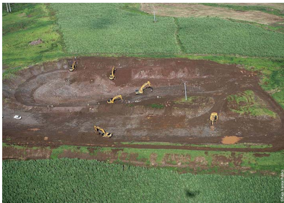
Photo 4 Terrassement d'un bassin Basin earthworks
