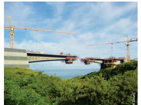
Pont sur la ravine Tabac Bridge over Tabac Ravine
