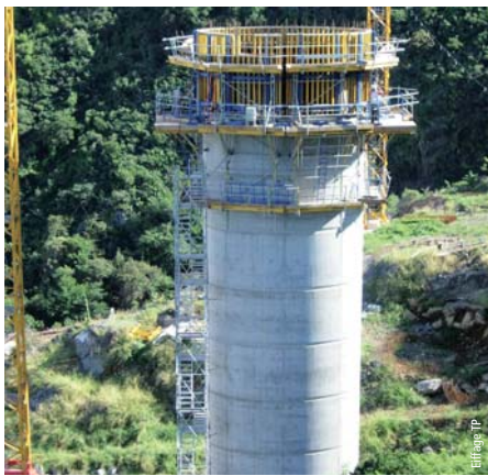
Photo 3 Coffrage des piles P1 et P2 Shuttering of piers P1 et P2
