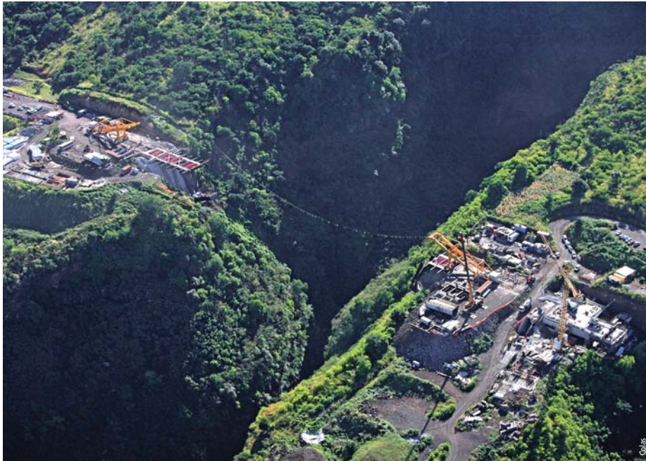
Photo 5 Avancement des travaux au 1 er juin 2008 Work progress on 1 June 2008
