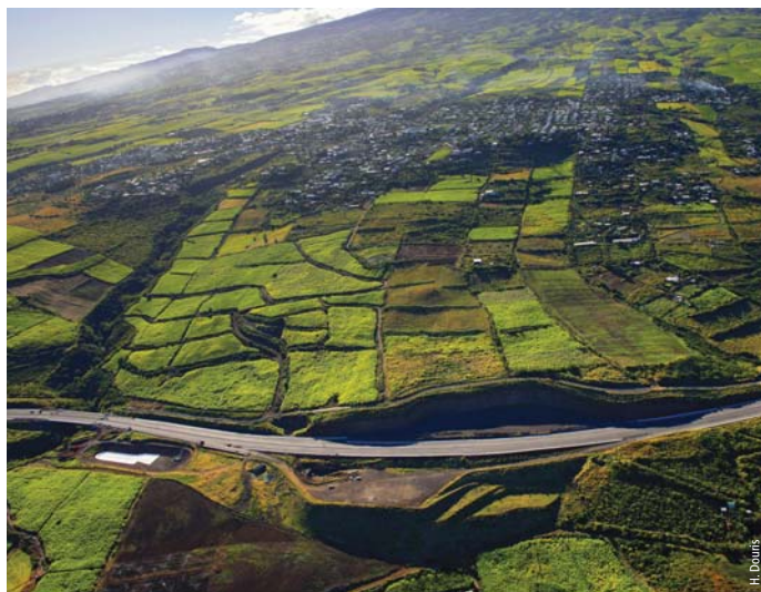
Photo 7 Terrassements généraux, aire de La Saline et champs de cannes (juin 2008) General earthworks, La Saline area and cane fields (June 2008)
