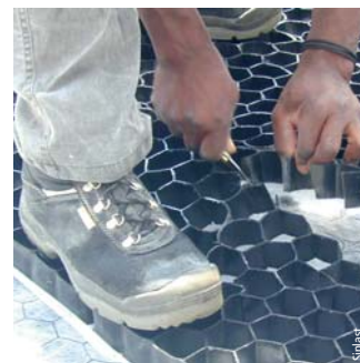
Les plaques Nidarooof se découpent aisément au cutter
