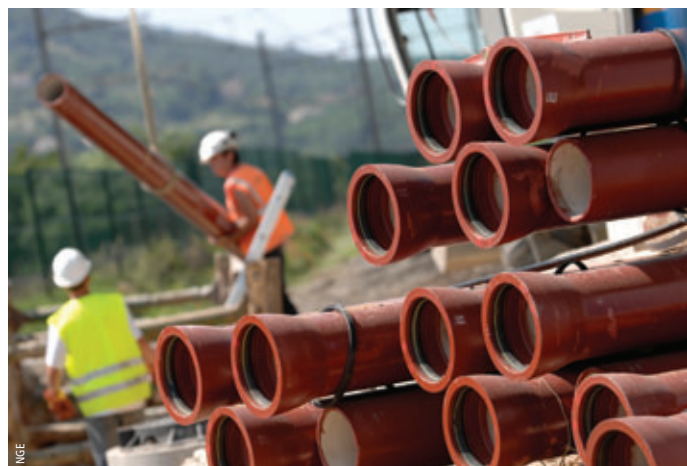
Photo 7 Travaux du tramway de Montpellier Montpellier tramway works
