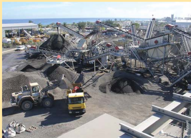
Installations de concassage SCPR – Le Port SCPR - Le Port crushing installations
