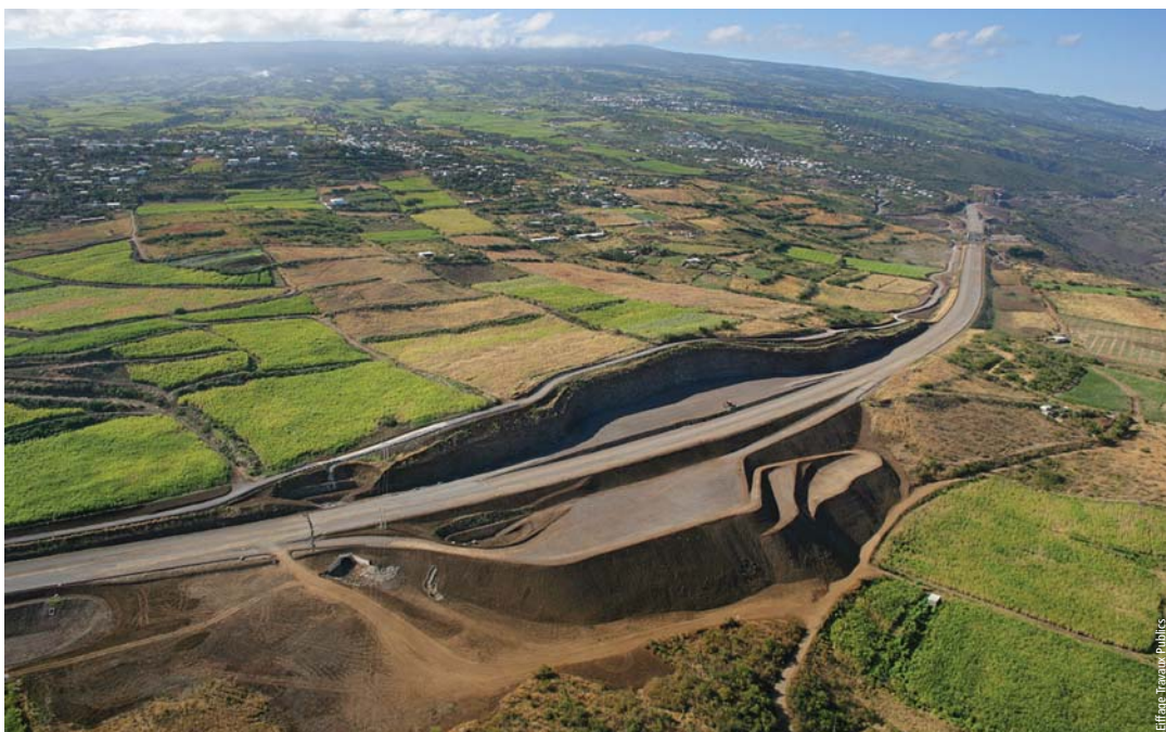
Vue aérienne du TOARC 1 Aerial view of TOARC 1 works
