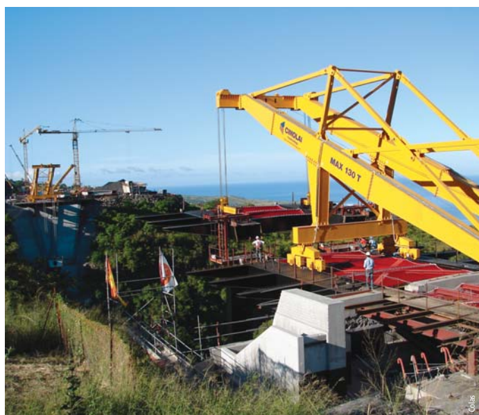
Photo 4a Pose du 2 e tronçon de tablier rive droite Placing of second right bank deck section
