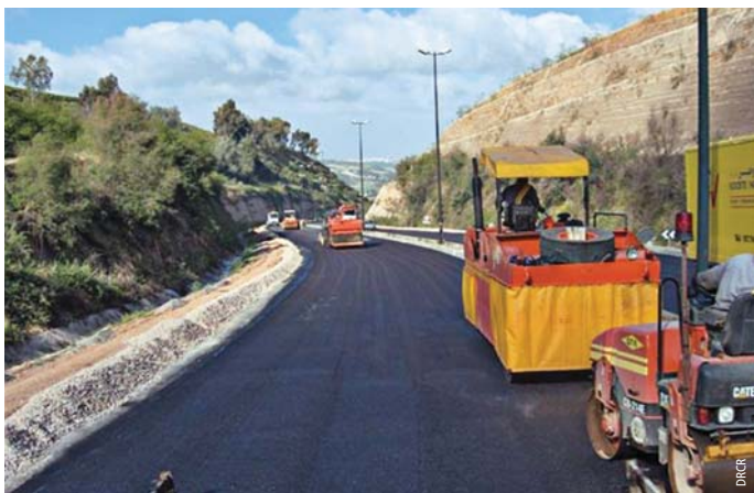
Photo 5 Application d'EME en couche de liaison sur la voie de contournement de Rabat - Salé
