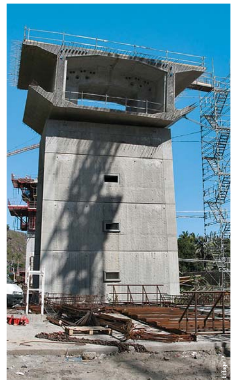
Photo 3 Pile et voussoir Pier and voussoir
