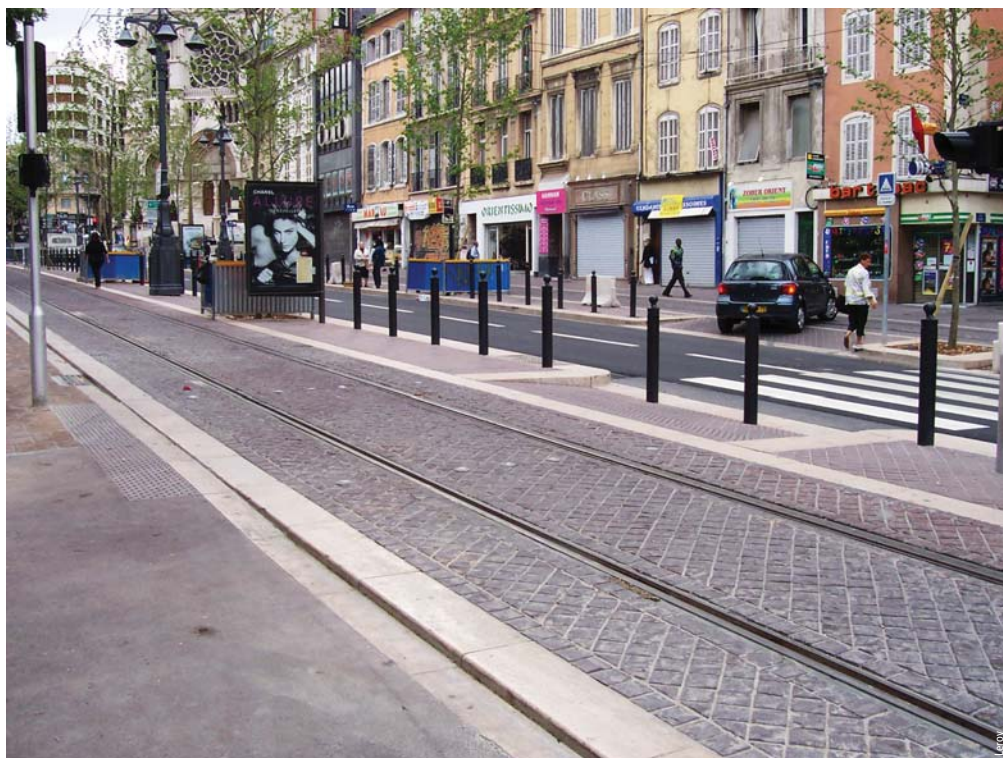
Voies tramway et voirie : une traversée accessible à Marseille Tramway tracks and roadways: accessible crossing in Marseilles
