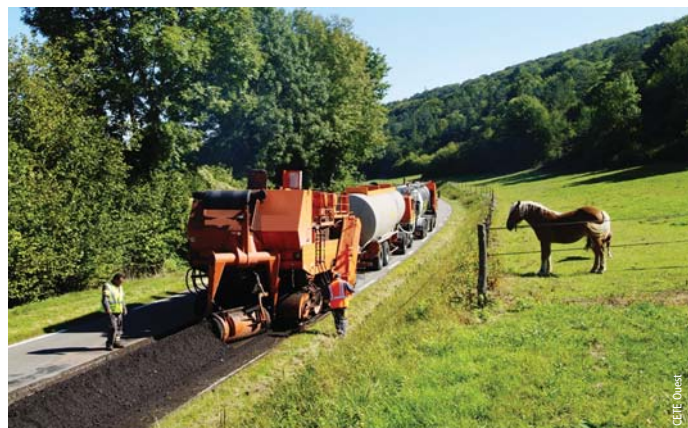
Réfection de voirie avec réutilisation in situ
