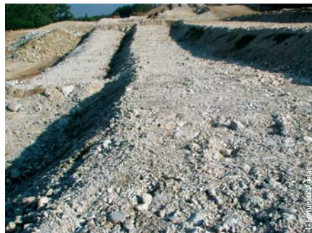
Photo 3 Tapis drainant sur redans Drainage blanket on stepping
