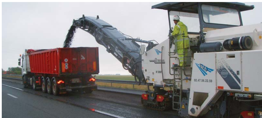
Déconstruction par fraisage d'un enrobé hydrocarboné de couche de roulement Deconstruction by milling of asphalt wearing course
