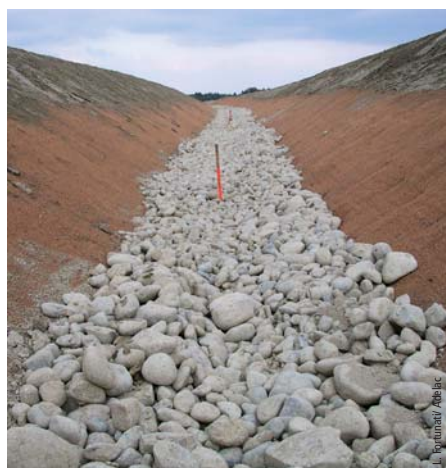
Photo 4 Ruisseau du Montailoux, détail d'aménagement du lit reconstitué – Utilisation de galets Montailoux Stream, restored bed development details – Use of pebbles
