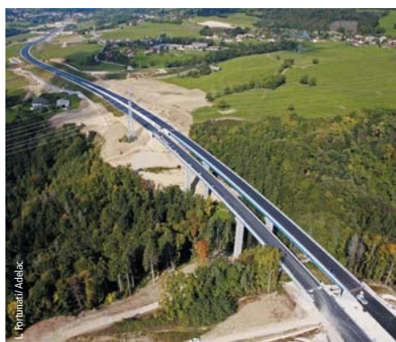
Photo 2 Vue du versant nord du viaduc du Nant de Saint-Martin View of the north slope of Nant de Saint-Martin viaduct
