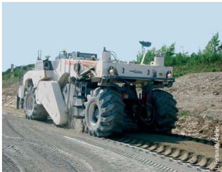
Photo 10 Traitement PST et CDF Formation level and capping layer surfacing
