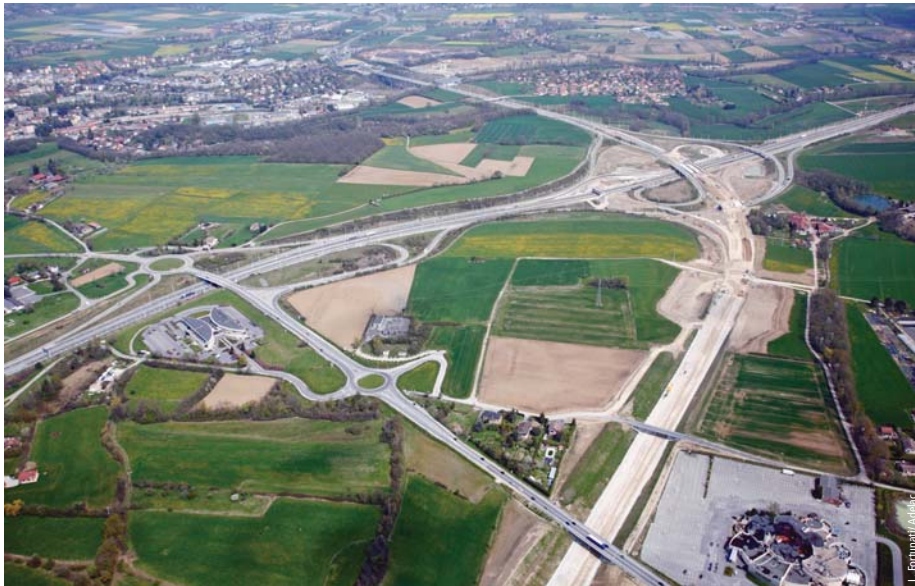
Photo 2 Nœud de Saint-Julien Saint-Julien interchange
