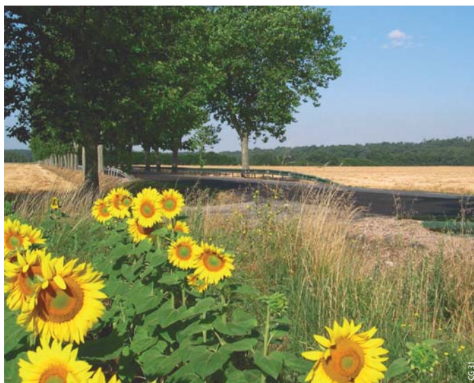
Recyclage des routes départementales : une politique de gestion et d'entretien du patrimoine routier prenant en compte les exigences environnementales Recycling of departmental (county) roads: a highway infrastructure management and maintenance policy that takes environmental factors into account.
