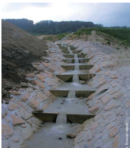
Photo 3 Ouvrage de rétablissement du ruisseau du Montailoux Montailoux Stream restoration structure
