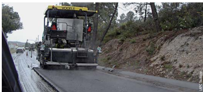
Photo 1 Mise en œuvre d'enrobés entre 60 °C et 80 °C, sur route nationale au Portugal (chantier de 24 km)
