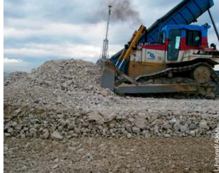
Photo 11 Mise en œuvre de la PST granulaire Application of granular formation level
