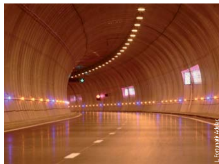
Photo 2 Vue de l'intérieur du tunnel View of tunnel interior
