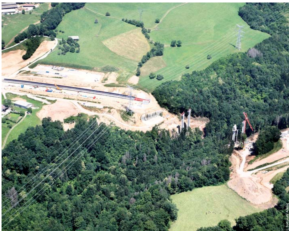
La construction du viaduc du Nant de Saint-Martin Construction of Nant de Saint-Martin viaduct
