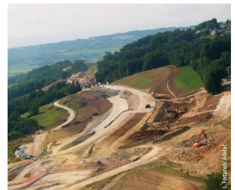
Photo 1 Versant au sud du viaduc de Pesse-Vieille Slope south of the Pesse-Vieille viaduct
