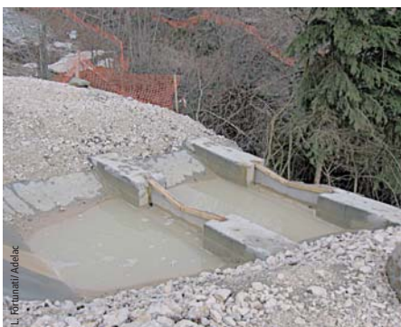
Photo 10 Assainissement provisoire – Dispositif béton en cascade avec filtre géotextile Temporary drainage – Cascade concrete system with geotextile filter
