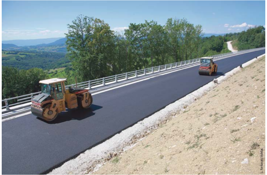
Réalisation des enrobés sur l'A41 Nord Application of asphalt on motorway A41 North
