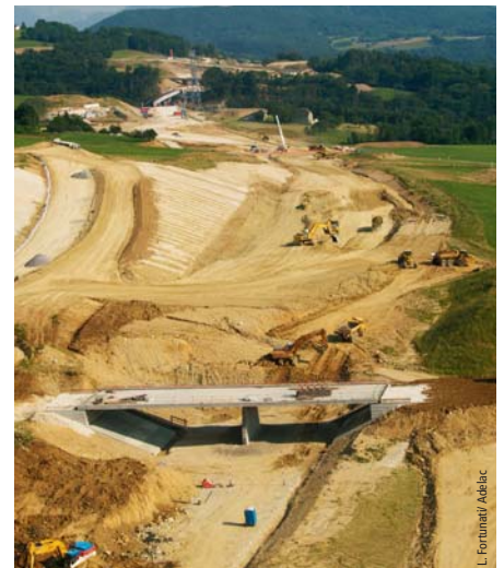
Photo 4 Stabilisation des talus de déblais par éperons drainants Stabilisation of earth cut embankments by trench drains
