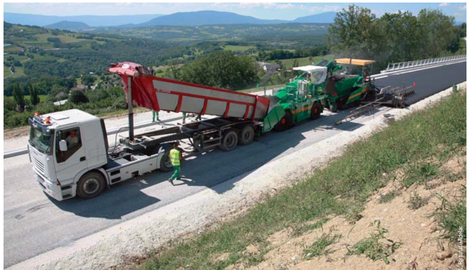
Photo 12 Réalisation des enrobés sur l'A41 Nord Application of asphalt on motorway A41 North
