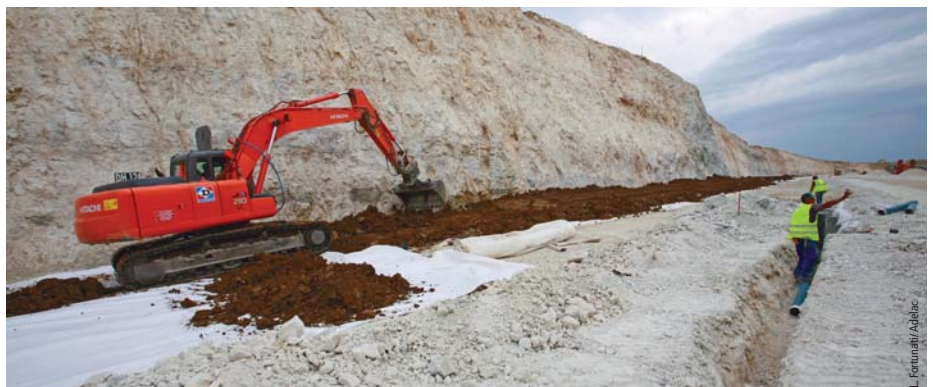
Photo 1 Tranchée du Noiret Noiret cut-and-cover
