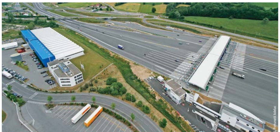
Photo 1 Réaliser, sous circulation, une barrière de péage pleine voie de 29 voies : l'un des défis relevés par les constructeurs de l'A41 Nord Construction of 29-lane full-width toll plaza under traffic: one of the challenges met by the A41 North building consortium
