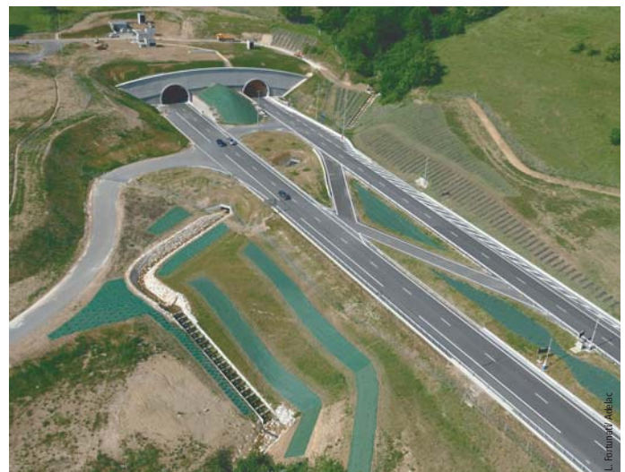
Photo 6 Tête sud du tunnel du Mont Sion South head of Mont Sion tunnel
