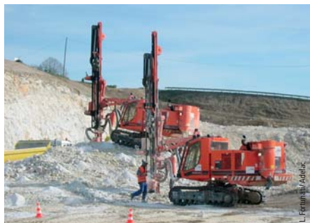
Photo 7 Minage au Noiret Blasting at Noiret
