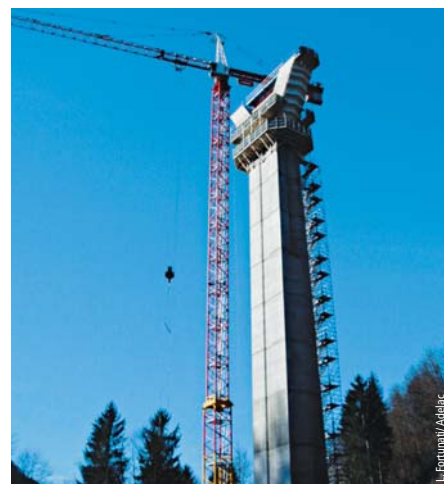
Photo 3 Pile P2 du viaduc des Ussets Pier P2 of Ussets viaduct
