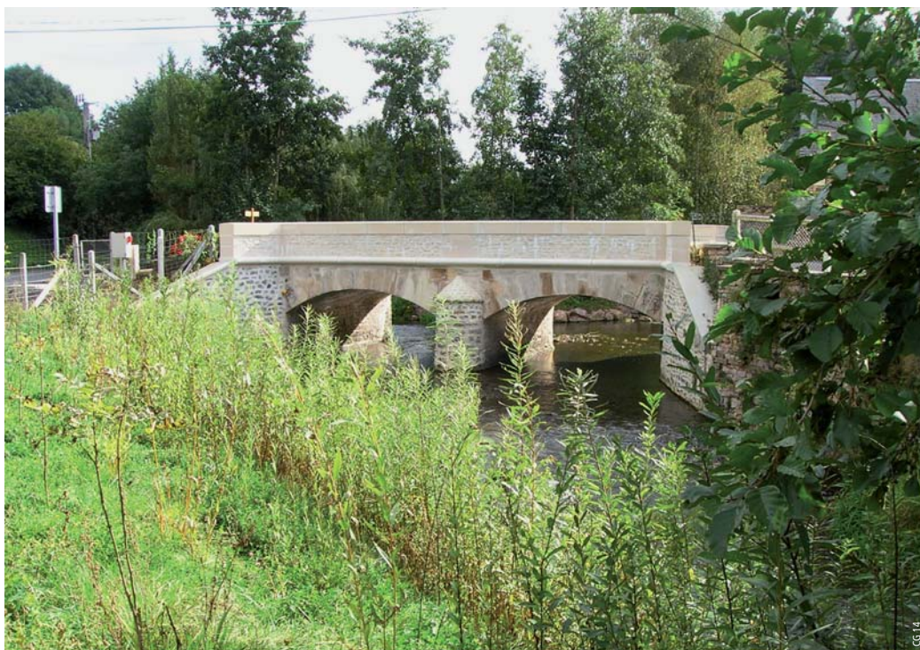
Route départementale 238b : réfection du pont de Jouette et aménagement des berges de la Laize à Fresnay-le-Puceux (Calvados)
