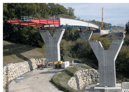
Photo 4 Tablier est du viaduc du Nant de Pesse-Vieille en cours de lançage Eastern deck of Nant de Pesse-Vieille en cours de lançage
