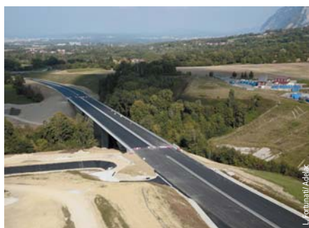
Photo 1 Vue générale du viaduc du Nant de la Folle General view of Nant de la Folle viaduct
