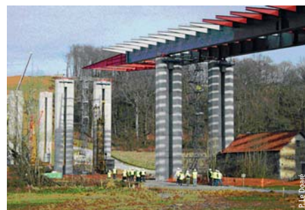
Phase de lancement du Viaduc du Gabas Gabas viaduct – Launch phase
