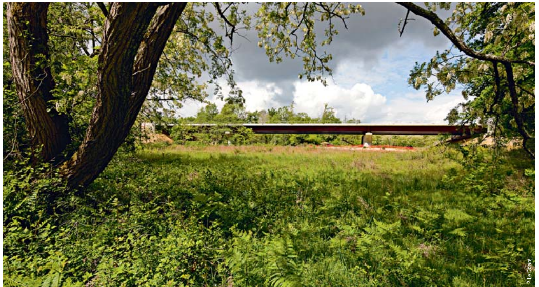
Viaduc du Ludon Ludon viaduct
