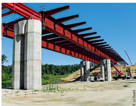
Viaduc de la Douze Douze viaduct
