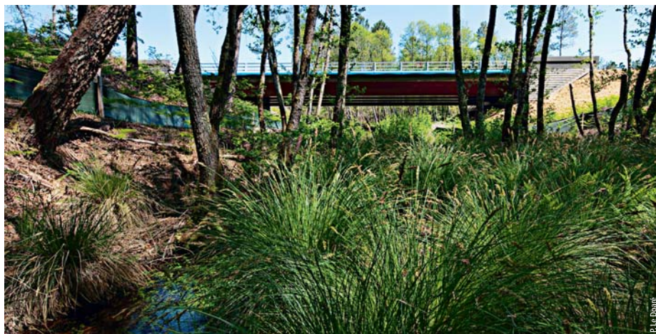
Photo 4 Viaduc du Ribarrou Ribarrou viaduct
