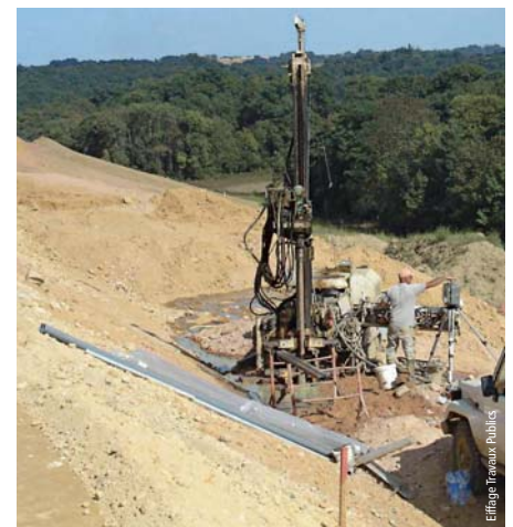
Photo 6 Réalisation d'un carottage avant pose d'un inclinomètre sur la risberme du R123 Core sampling before placing of inclinometer on berm on road R123
