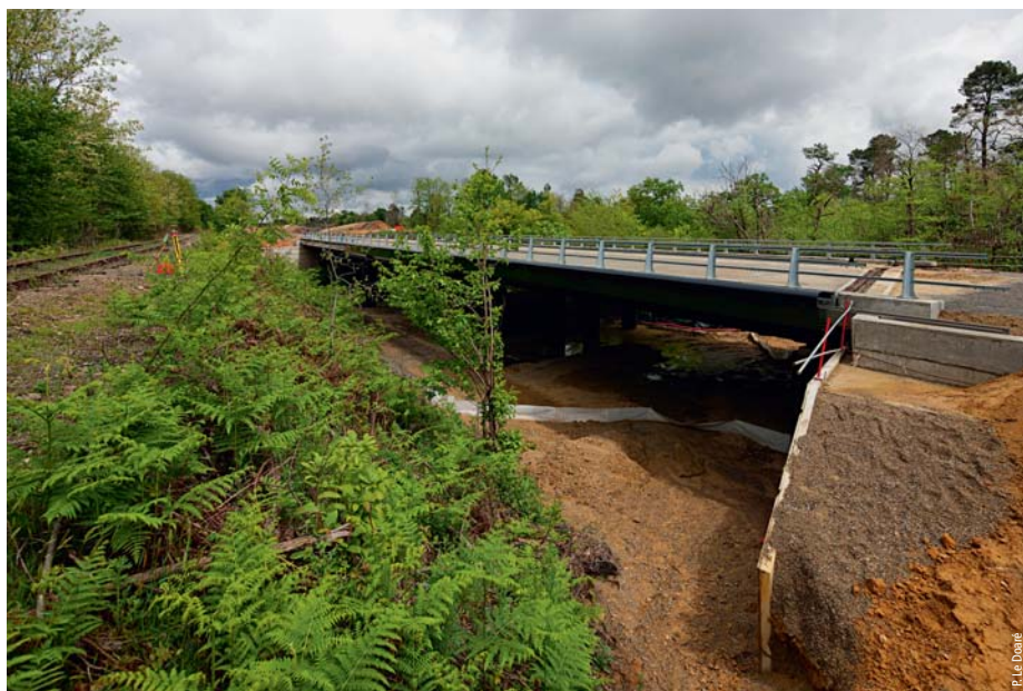
Photo 6 Viaduc sur la rivière des neufs fontaines Viaduct on Neufs Fontaines River
