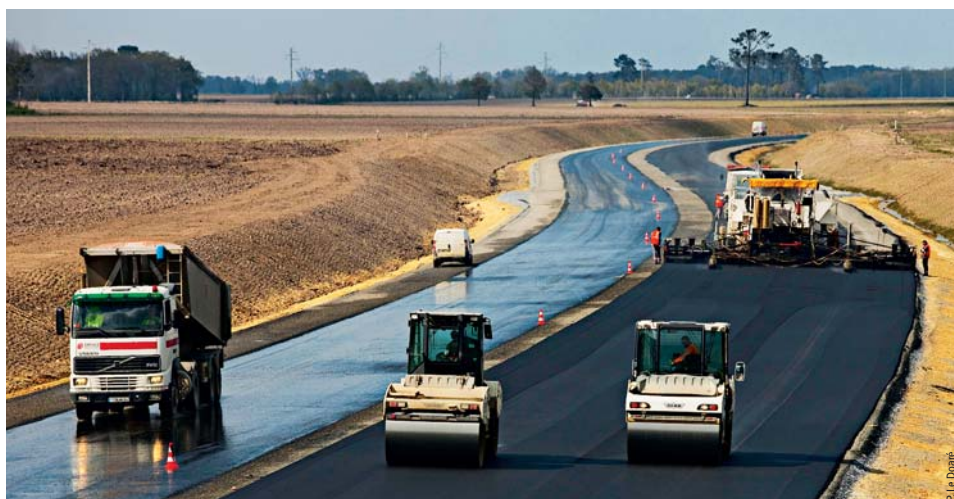
Mise en œuvre de la grave-bitume Application of asphalt roadbase material
