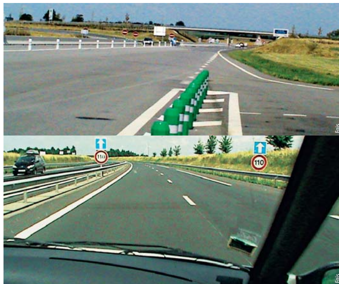
Sections amont (en haut) et aval (en bas) de l'A88 Sections upstream (top) and downstream (bottom) of A88
