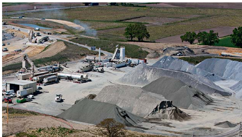
Photo 1 Plate-forme de Thèze (lot sud) Thèze roadbed (south section)
