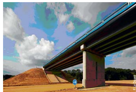
Passage supérieur de type PRAD PRAD-type overpass
