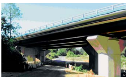
Piles du Viaduc du Bartouquet Bartouquet viaduct – Pillars
