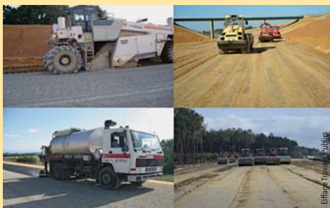
Photo 2 Ateliers de mise en œuvre et compactage de la couche de forme traitée Application and compacting equipment for improved subgrade
