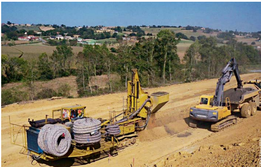
Photo 4 Réalisation de tranchée drainante profonde Provision of deep drainage trench
