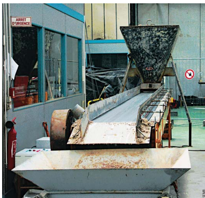
Photo 2 Vue du tapis extracteur, de la trémie de stockage (arrière-plan) et de la trémie de transvasement (premier plan) View of extraction hopper (background) and transfer hopper (foreground)
