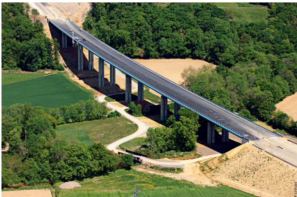
Le viaduc du Gabas (444 m) Gabas viaduct (444 m)
