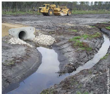
Photo 2 Traversée du plateau landais en remblai rasant Crossing of Landes plateau with shallow embankment fills
