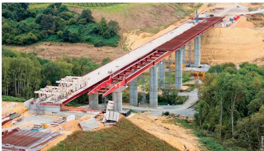
Viaduc du Riumayou Riumayou viaduct
