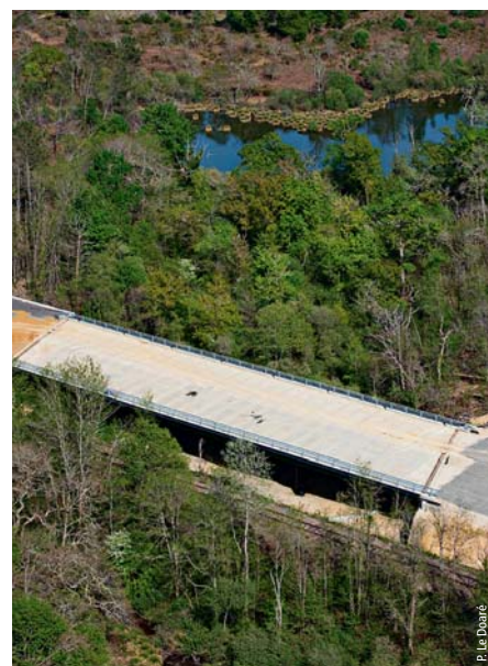
Photo 2 Viaduc de Bostens Bostens viaduct
