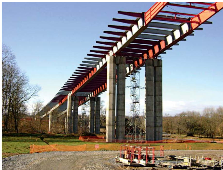
Photo 3 Viaduc du Gabas et conservation d'un vieux moulin à chiroptères Gabas viaduct and conservation of an old chiropteran mill (for bats)
