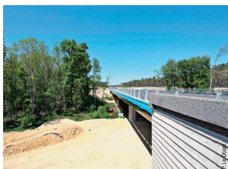
Viaduc du Retjons Retjons viaduct
