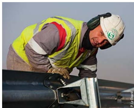
Photo 5 Pose de glissières de sécurité Installation of guardrails
