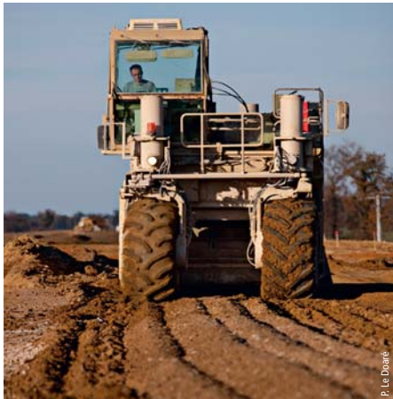
Photo 4 Traitement en place In-place treatment
