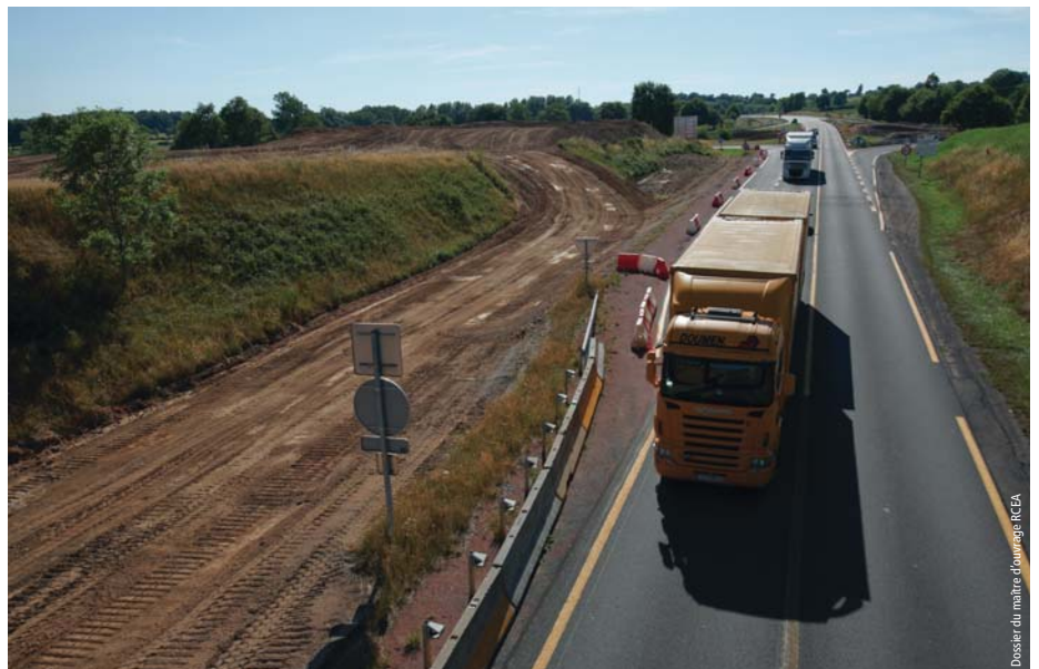
Photo 2 Des travaux très attendus Works long awaited
