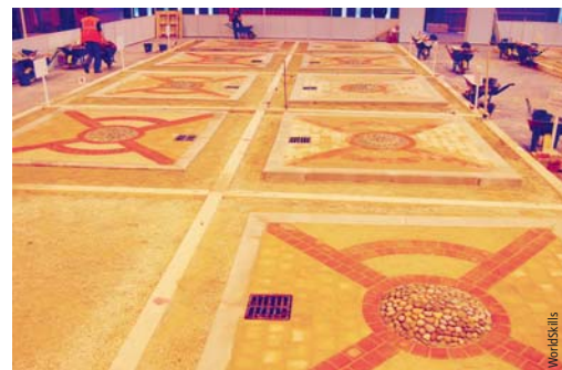
Les pavages réalisés
