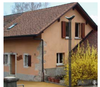
Implantation de l'ensemble à LED Kaïdo Line à Concise (Suisse)
