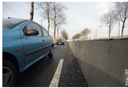
Chantier en cours du tramway du Havre Le Havre tramway worksite in progress
