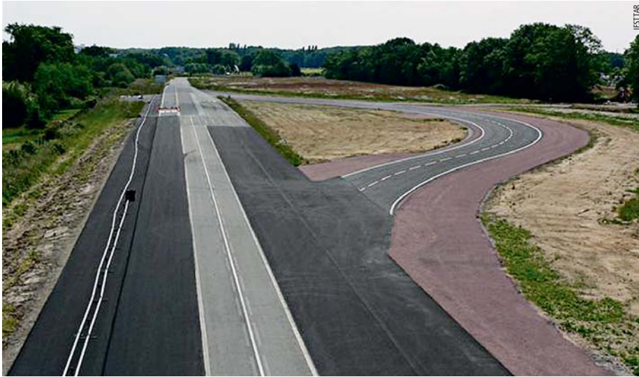
Photo 1 Piste d'essai : virage de test encadré de clothoïdes à droite Test circuit: test bend framed by clothoid on right
