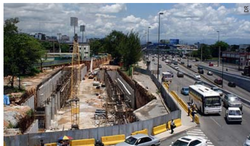
Construction de la ligne 2 du métro de Saint-Domingue
