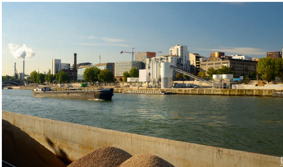
Nouvelle centrale haute qualité environnementale (HQE) de Paris Tolbiac
