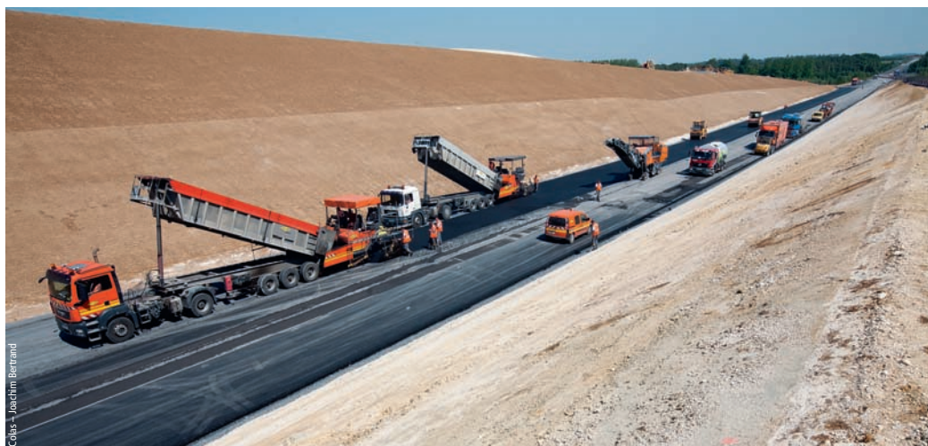
Chantier de construction de l'A29 à hauteur de Licourt (80)
