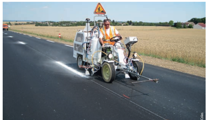
Application du marquage avec machine G 400 sur RD 928 Application of marking with machine G 400 on highway RD928
