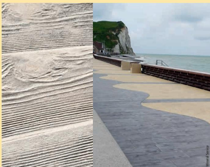
Finition : **béton imprimé**
