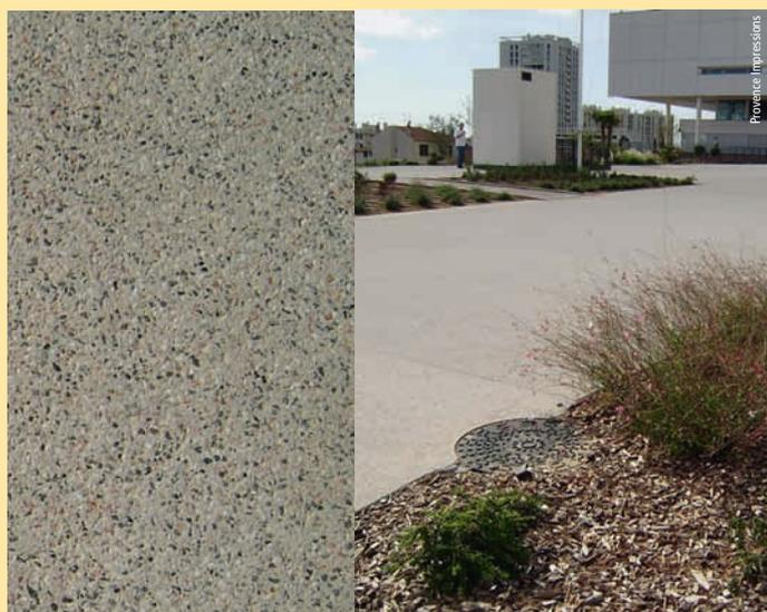
Finition : **béton hydrosablé**
