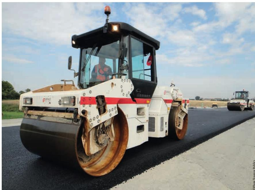
Mise en œuvre de grave-bitume GB5® 0/14 sur le raccordement A13 – RD 613 (Sanef)
