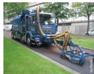
Mise en couleur d'une voie de bus du Trans-Val-de-Marne (TVM) à Créteil (94)
