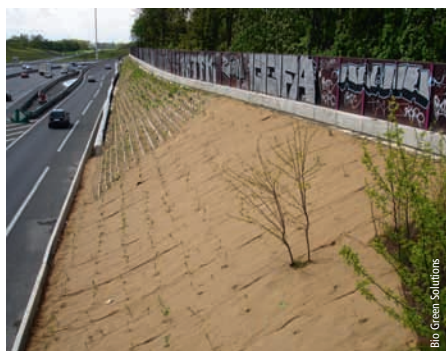
Couverture anti-érosive au bord de l'A104
