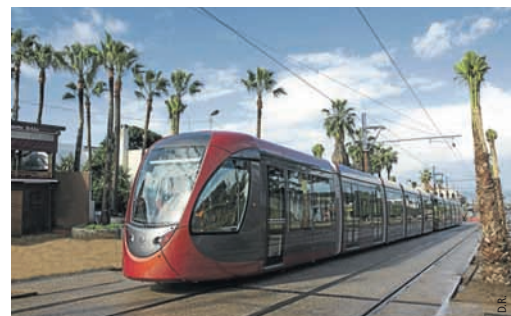
2 000 palmiers ont été plantés tout au long du tracé du tracé
