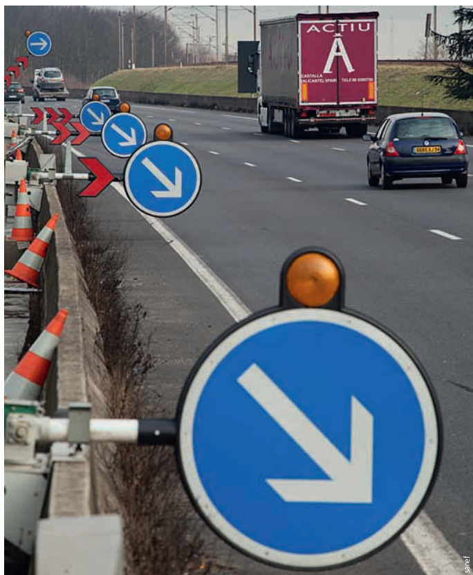
Photo 6 Les BRA au niveau de Roissy sur l'A1 Lane merge arrows near Roissy on motorway A1
