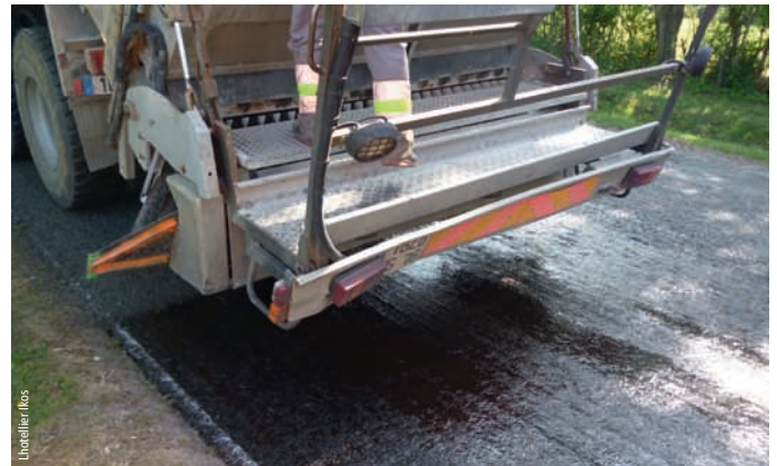
Photo 4 Application des gravillons sur le sandwich liant/fils de verre/liant en première phase Application of chippings on binder/glass thread binder sandwich in first phase
