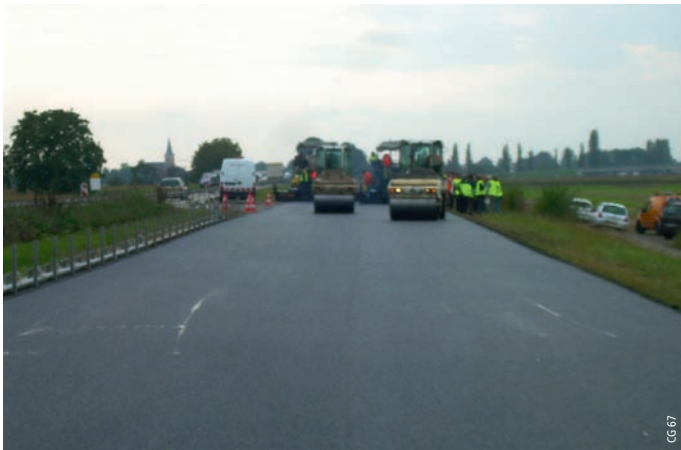
Photo 5 Compactage du SMA sur la RD 1083 Compacting of SMA on highway RD 1083
