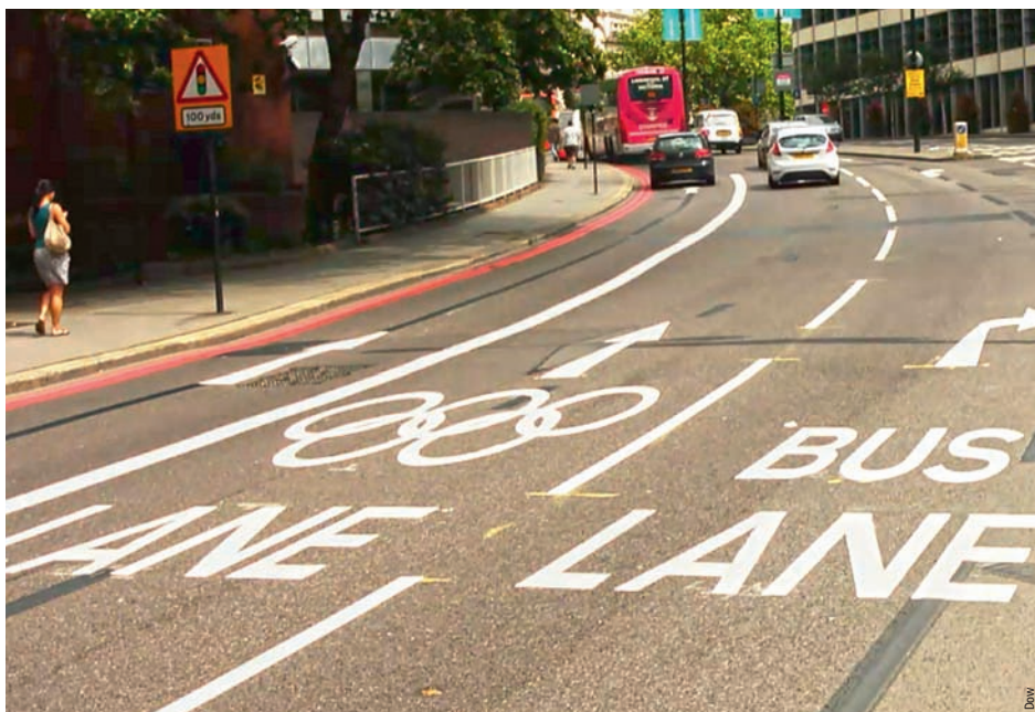
Londres Jeux Olympiques 2012 – Peintures à l'eau pour matérialiser des voies réservées aux convois officiels et aux athlètes
