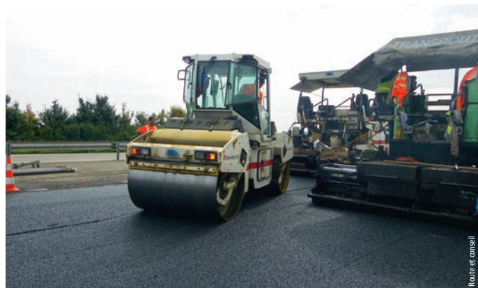
Photo 3 Mise en œuvre du SMA Application of SMA
