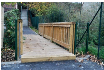
Passerelle mixte bois-métal conforme aux normes pour la protection des piétons et durable par l'intégration d'une structure métallique en acier mécano-soudé
