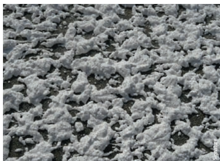
Grenade, enduit à froid structuré de type crépi, VNTP P5, routier et urbain drainant Grenade, cold road marking-structured, rough cast, VNTP P5 (visible at night in rain), road and city, porous
