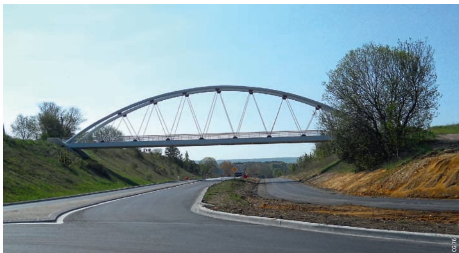
Photo 2 Passerelle pour piétons de La Mailleraye La Mailleraye footbridge
