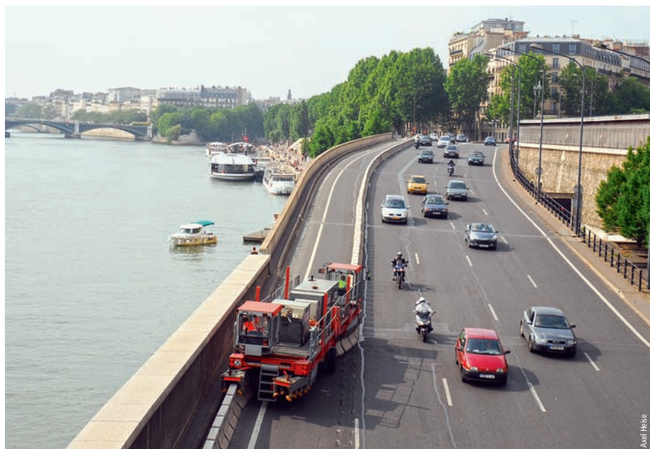
Chantier de balisage lourd pour la fermeture de la voie express rive droite réalisé pour la Ville de Paris par les équipes de Signature Ile-de-France Heavy marking worksite for closing of right bank expressway completed for City of Paris by Signature Ile-de-France crews
