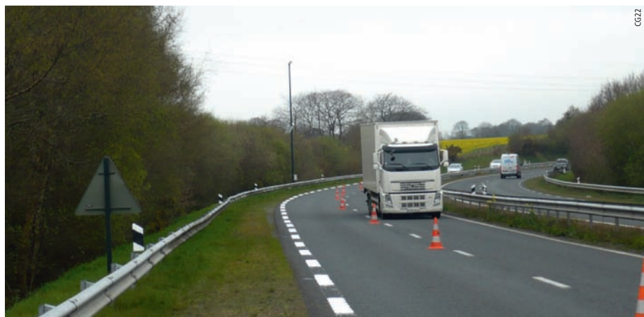
Ligne d'alerte audiotactile en rive - RD 767 Audio-tactile warning line on edge, departmental road RD767
