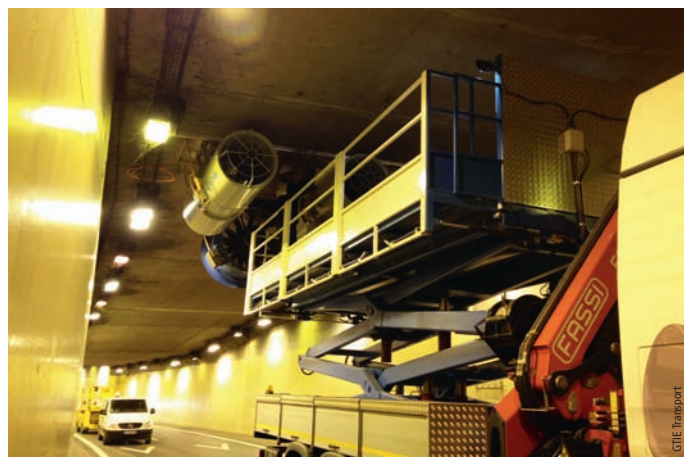
Photo 2 Nacelle pour pose et dépose des anciens et nouveaux ventilateurs Cradle for installation and removal of old and new fans
