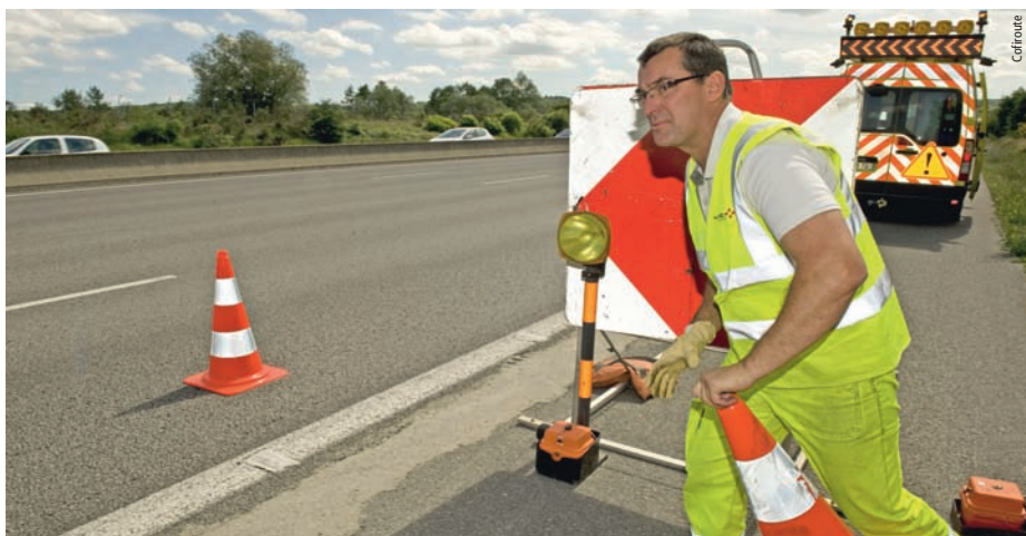
Photo 2 Le balisage est le 1 er risque d'accident pour le personnel Marker placement is primary accident risk for personnel
